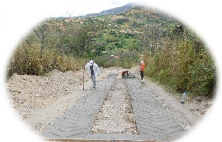
CONSTRUCCIÓN DE HUELLAS VEHICULARES
