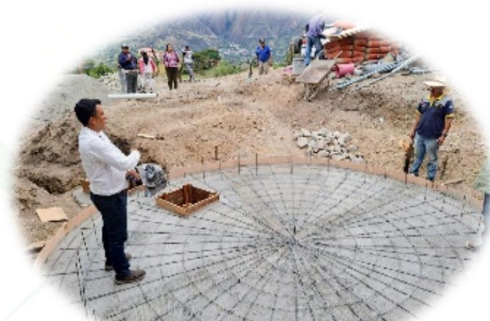
ETAPA DE CONSTRUCCIÓN DEL TANQUE
