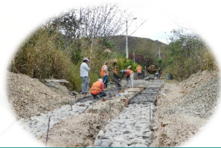
CONSTRUCCIÓN DE HUELLAS VEHICULARES
